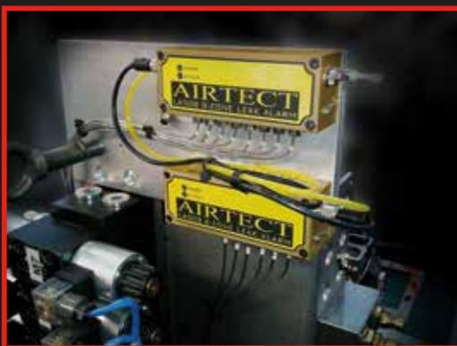
Installatie van verdelers
